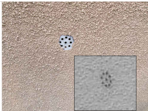
Při opravách krytky vyčistit střík. strukturu a malbou - zachovat větrací otvory !
